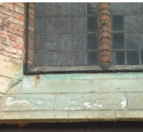
Kopergaas oxideert, waarna het door de regen afgespoelde, groene koperoxide de afzaat onder het venster vervuult, net zoals het roestwater van de bevestigingspunten
